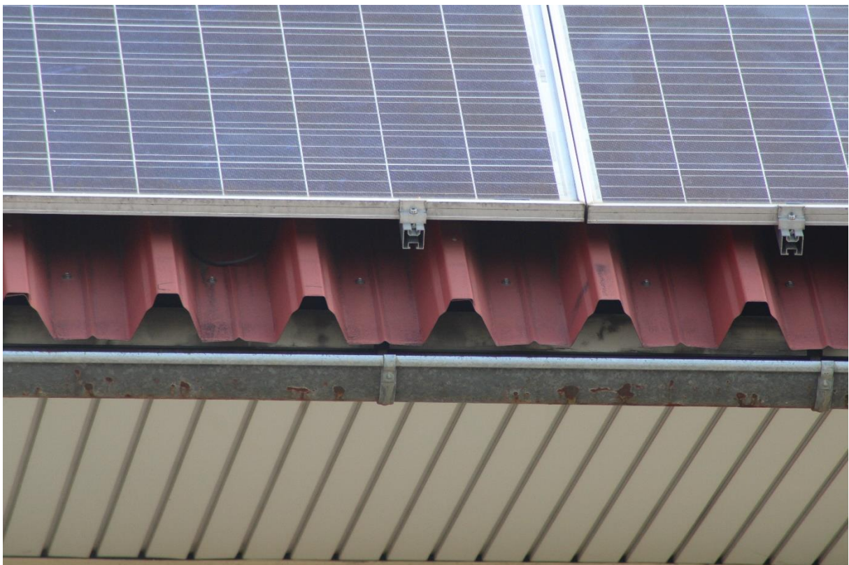
Abbildung 22: Einflugmöglichkeiten unter Dachflächenphotovoltaikanlage
