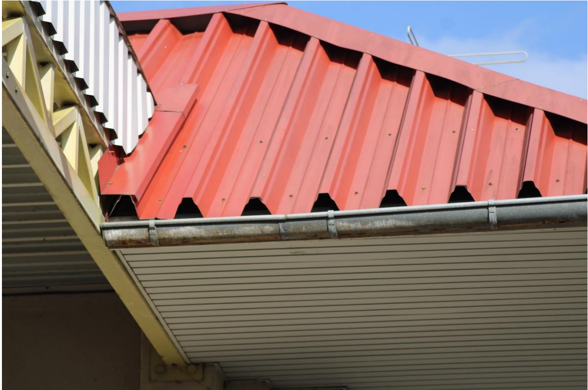
Abbildung 21: Einflugmöglichkeiten Dachverkleidung
