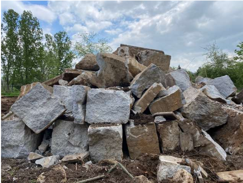
Abbildung 5: Teil der entfernten Betonummantelungen der Entwässerungsleitungen (Quelle: C. Böhler, Datum der Aufnahme: 04.05.2021)
