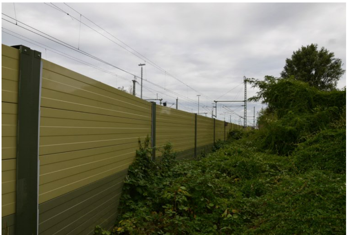
Bild 6: Nahansicht der Lärmschutzwand
