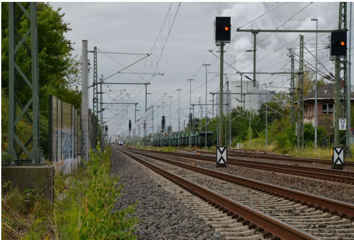
Bild 8: Blick vom nördlichen Ende der Lärmschutzwand nach Süden entlang der Gleisanlagen
