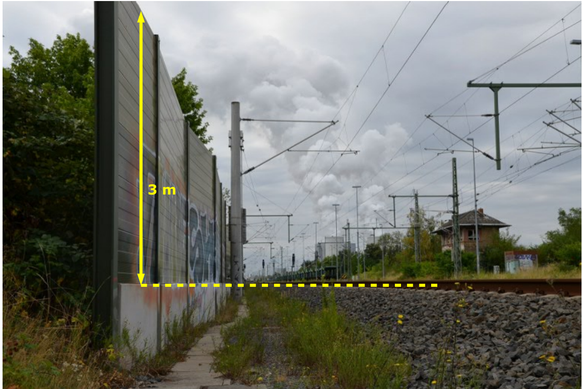
Bild 9: Blick zum nördlichen Ende der Lärmschutzwand mit Höhenbestimmung
